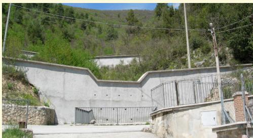
Fig. 27 - Le briglie costruite lungo il torrente Baroncelli, a monte di Grotti.
